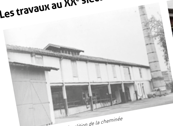
La laiterie avant la démolition de la cheminée
